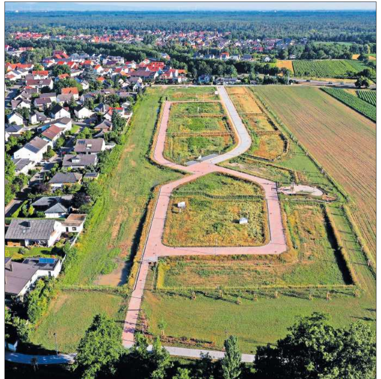
Knapp fünf Hektar groß: das Baugebiet „In den Dreißig Morgen“.
